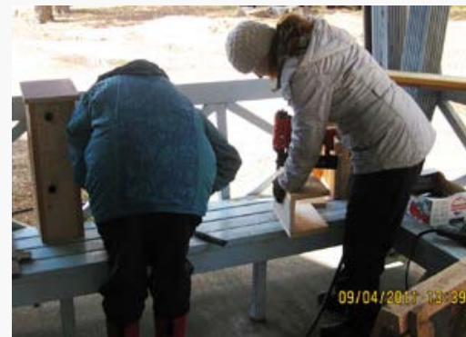
Pienimuotoinen uudisrakentaminen vauhdissa
