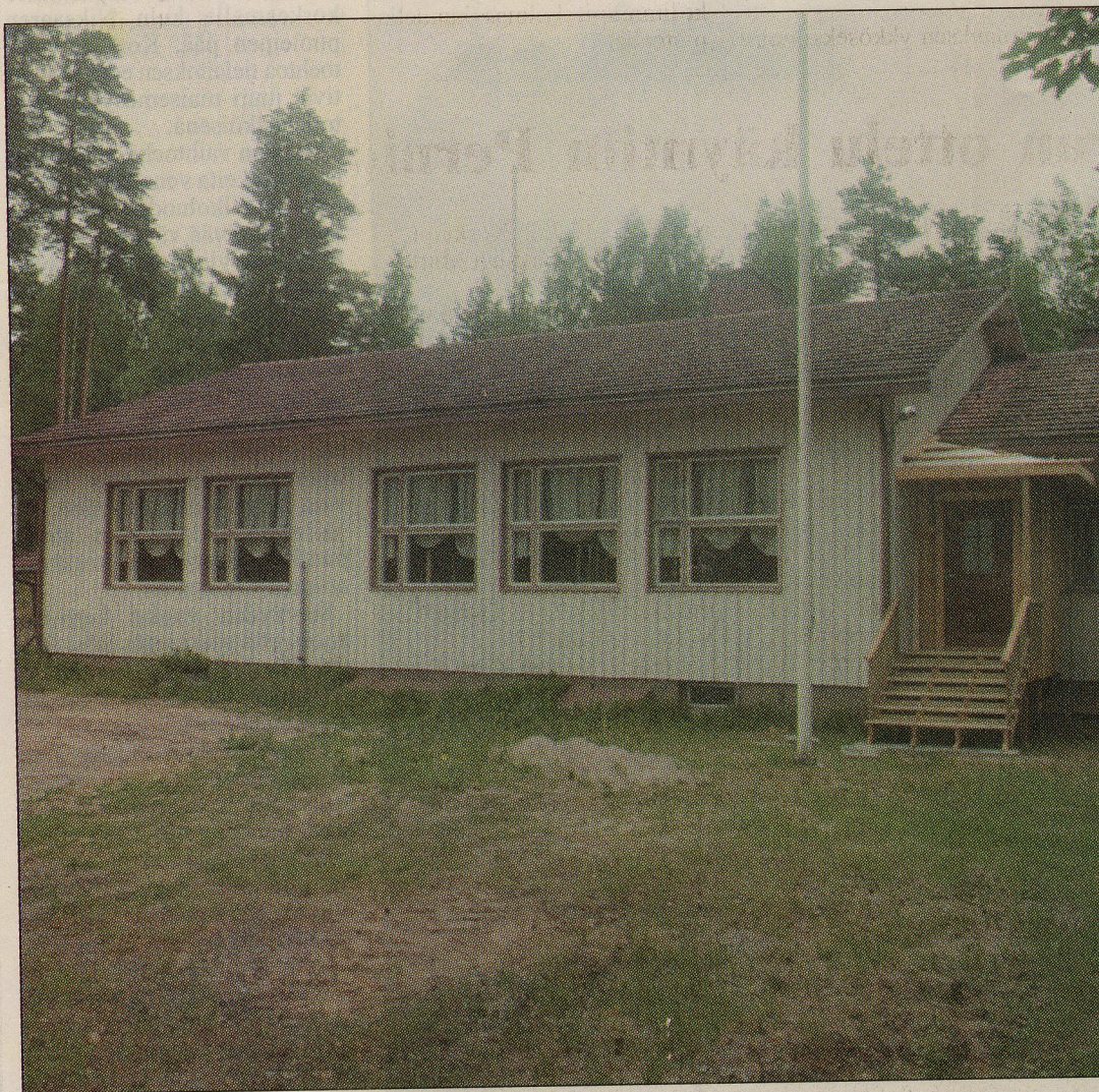
Tuohittulaiset ovat rakentaneet vanhaan kouluun ryhmistä varten uuden sisäänkäynnin. Talon kattoa leikkiapaikkakin.
